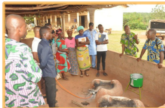
Installation du biodigesteur dans la cantine de l'école publique d'Agbonan ©CIPRE-Bénin
