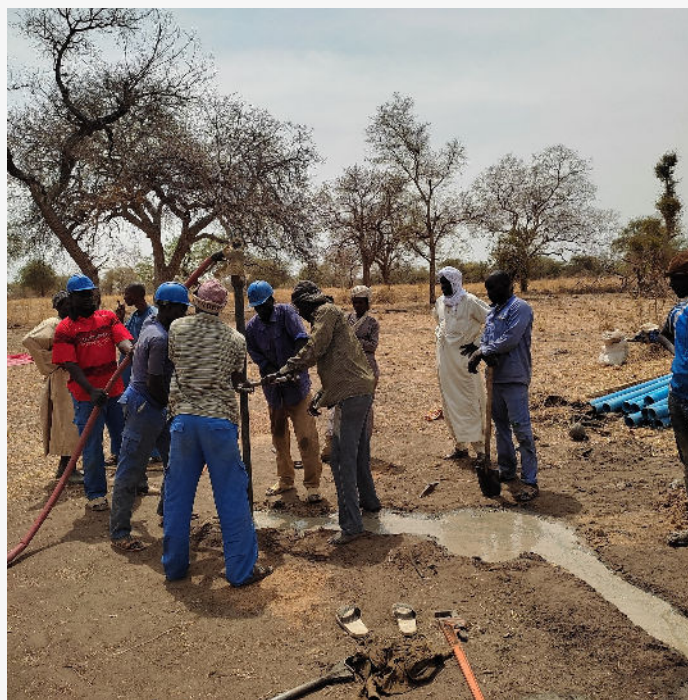
Tchad, Batimera : réparation d'un forage.
