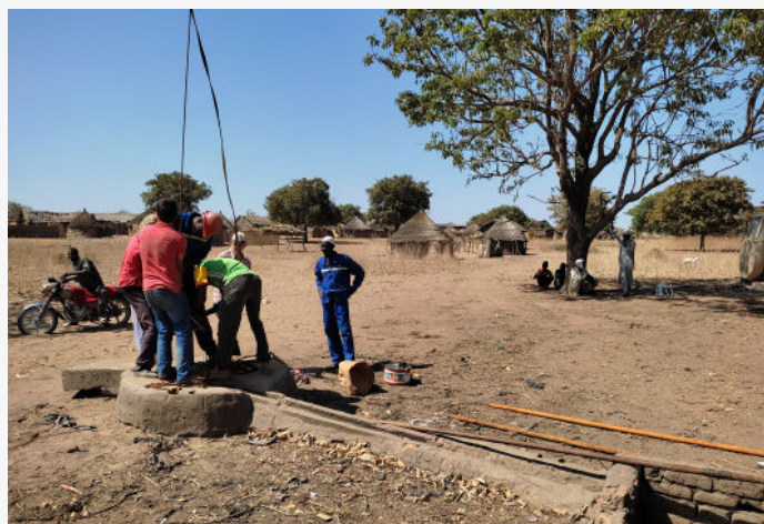
Tchad, Batimera : réparation d'un forage.
