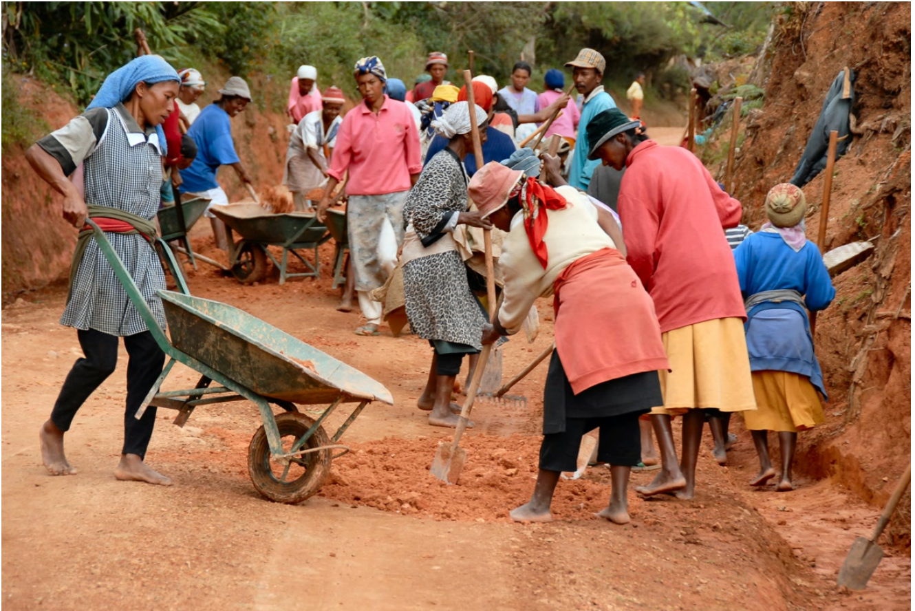
Chantier sur une route © Albert Huber pour Défap
