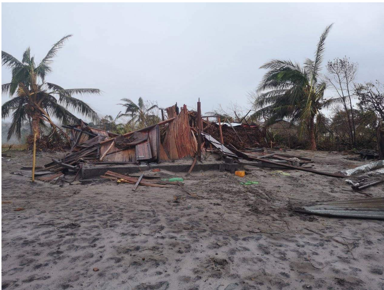
Dégâts du cyclone Batsirai © FJKM
