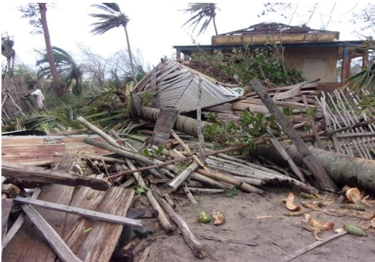
Vue des dégâts après le passage du cyclone Batsirai au centre
