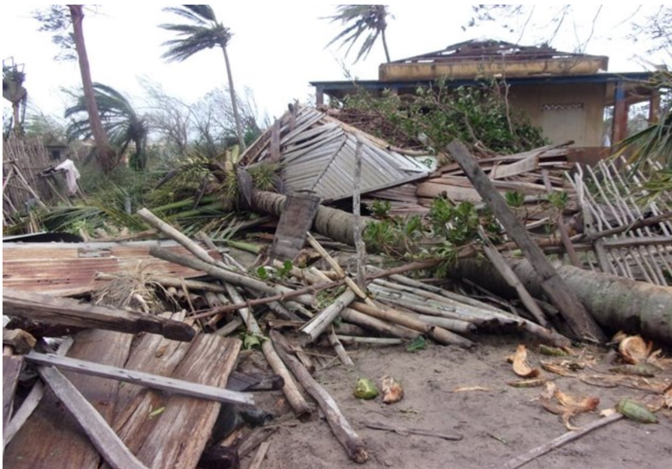
Vue des dégâts après le passage du cyclone Batsirai au centre Akany Fanantenana © La Cause
