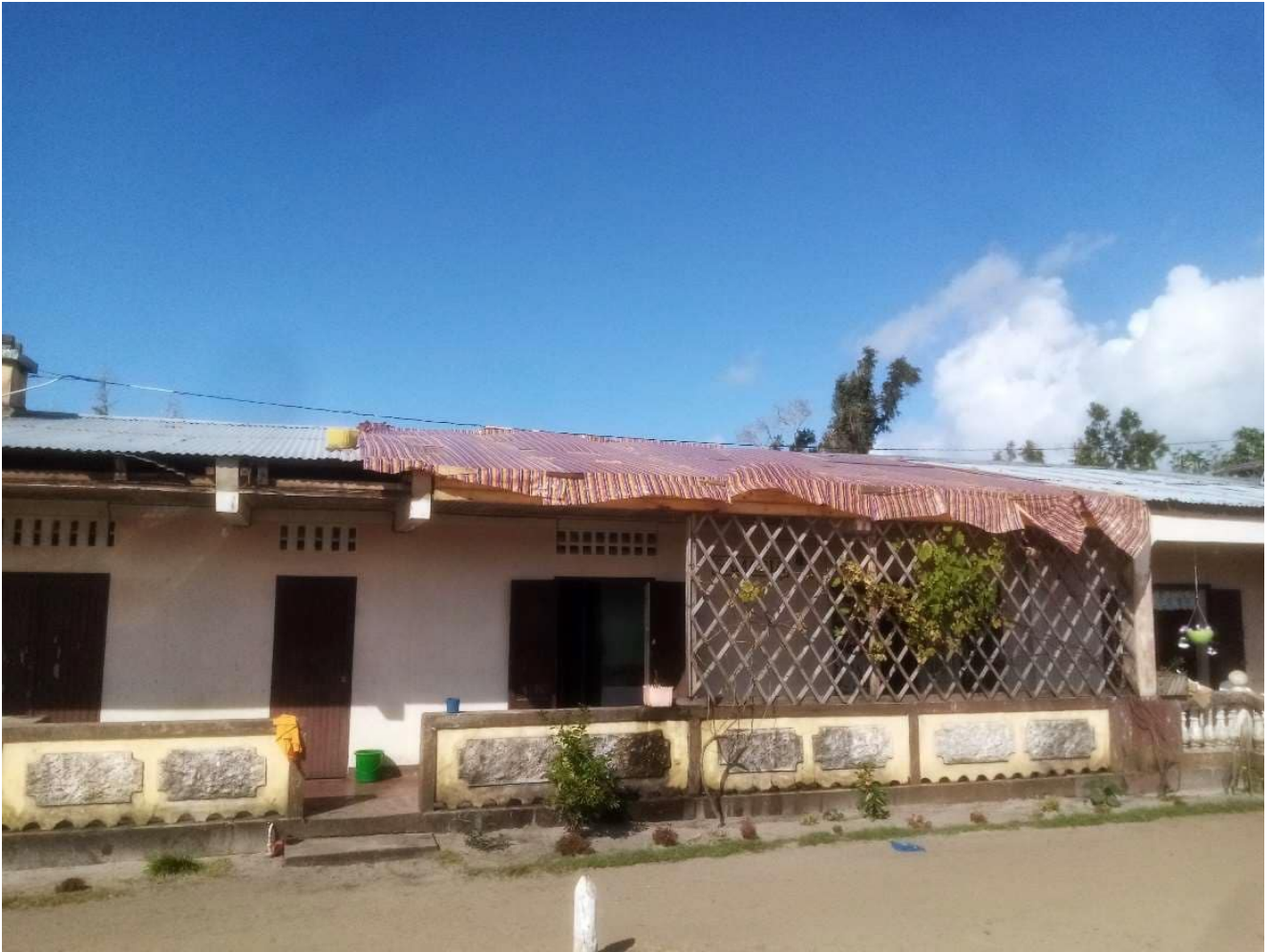
Pose d'une nouvelle charpente au Catja © ADRA
