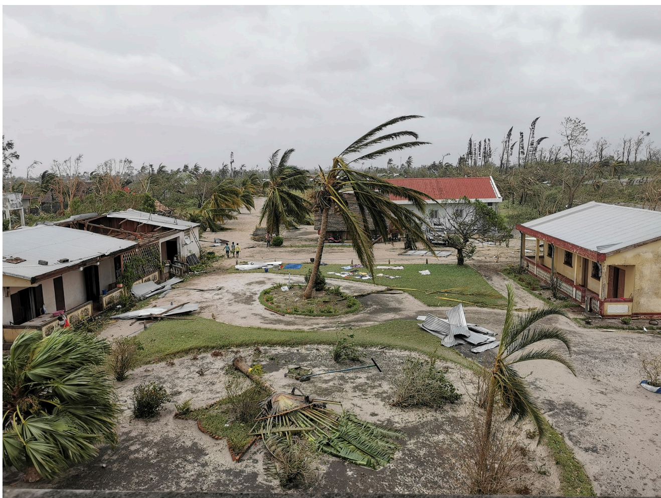
Une image datant de début février : les dégâts du cyclone Batsirai au Catja © Catja
