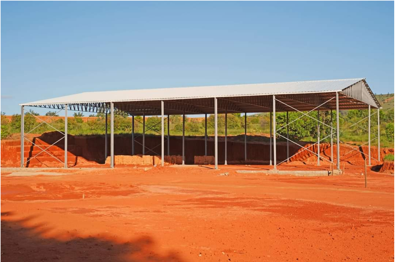
Les bâtiments sortent de terre © Romain pour Défap
