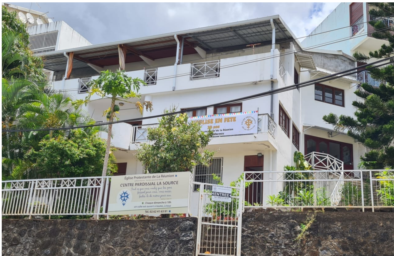
Le centre paroissial « La Source », à Saint-Denis, dans le Nord de l'île © EPR
