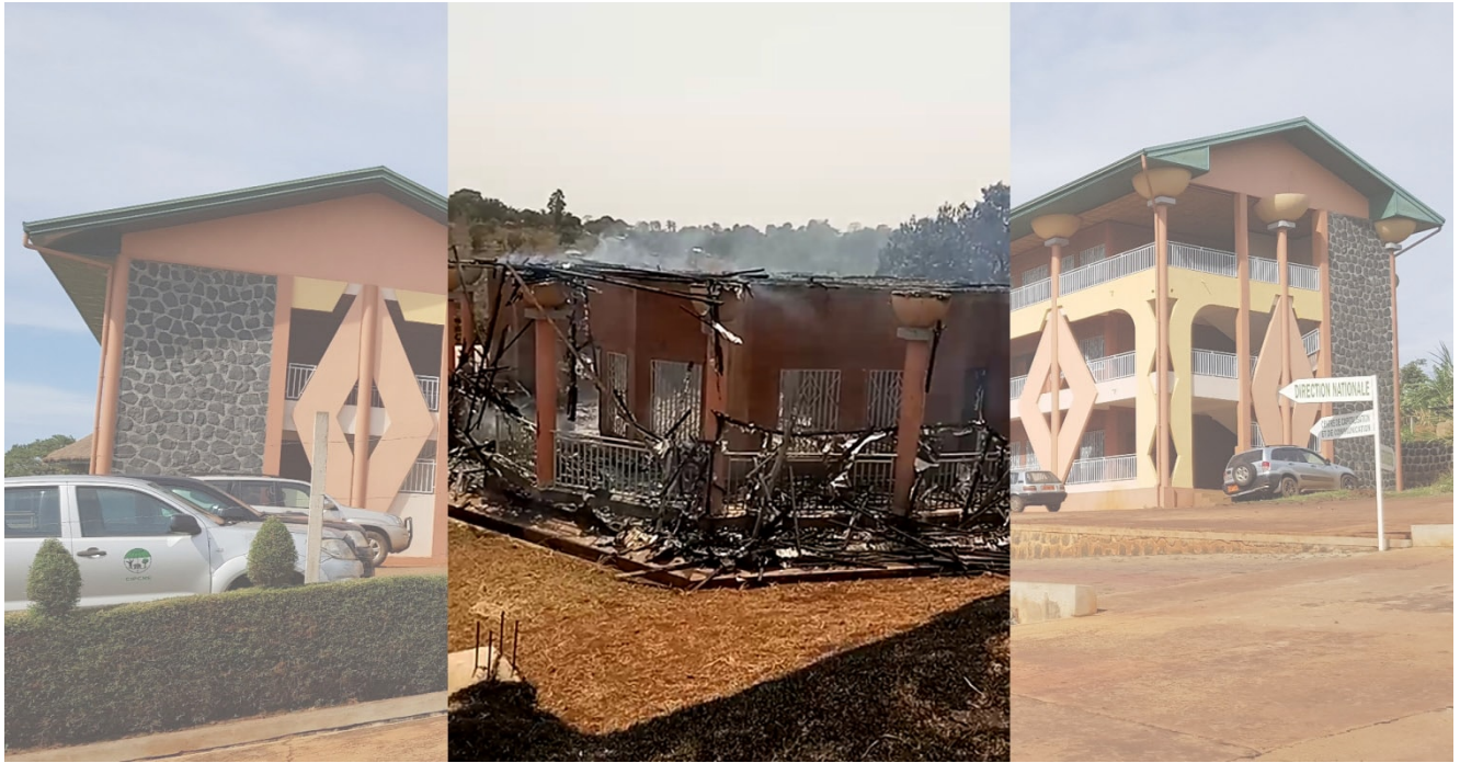
Le siège du CIPCRE, avant et après l'incendie : deux bâtiments ont été ravagés © CIPCRE
