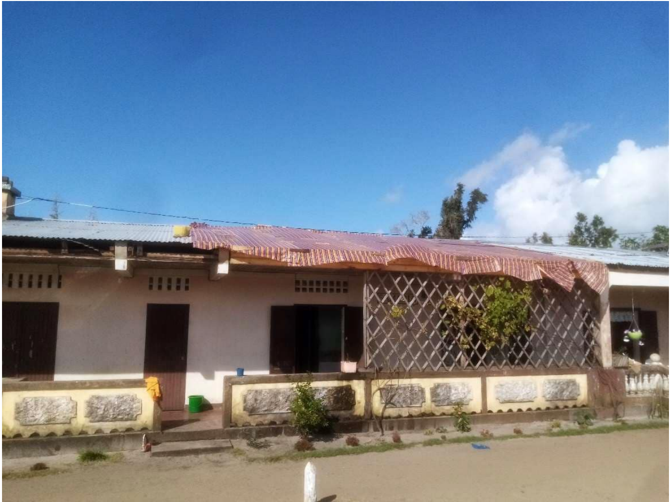
Pose d'une nouvelle charpente au Catja © ADRA
