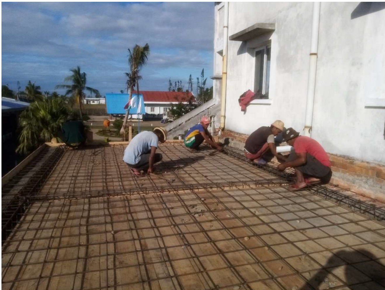
Mise en place d'une dalle de béton sur un bâtiment du Catja © ADRA
