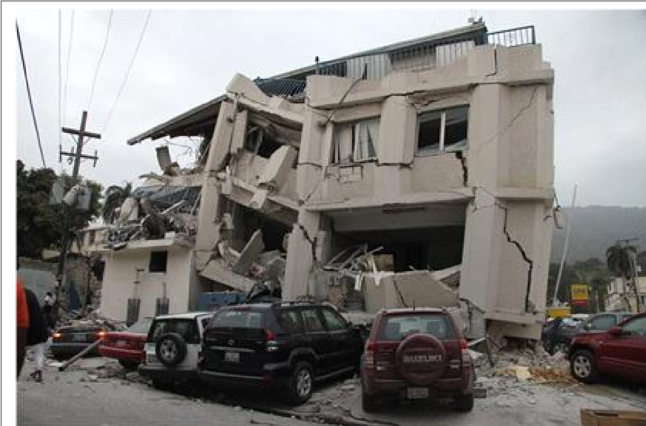
Bâtiment endommagé par le séisme © FEPH
