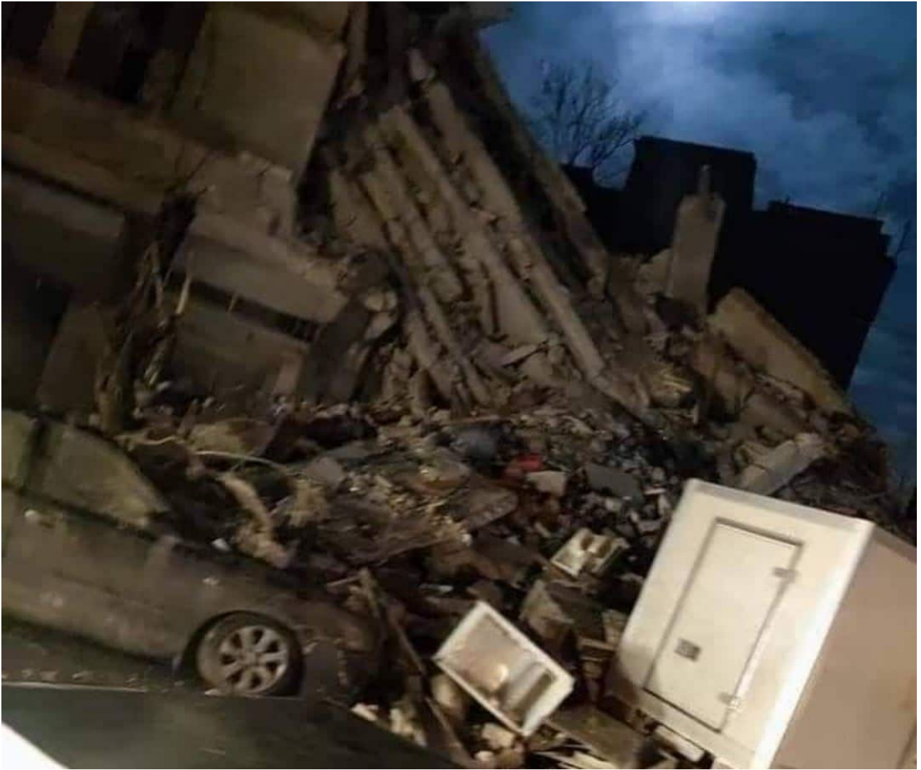
Image des dégâts du séisme à Alep © Presbyterian Church of Aleppo
