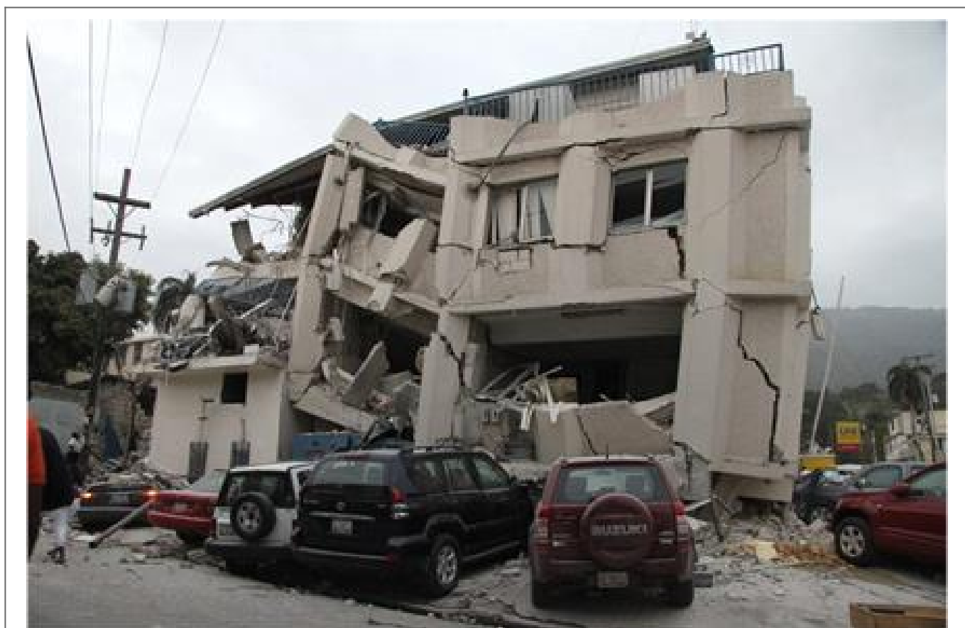
Bâtiment endommagé par le séisme © FEPH
