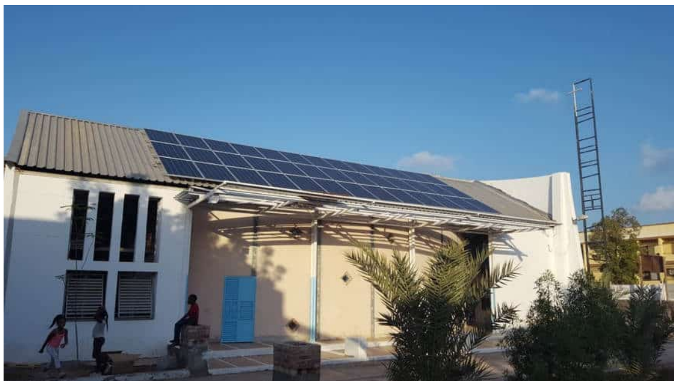
Panneaux solaires au centre de formation de l'EPED © EPED
