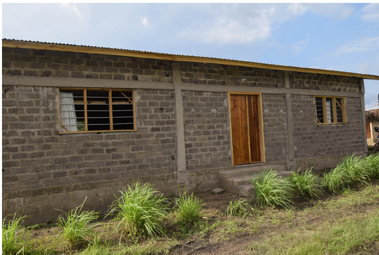
La salle de formation construite au niveau de la ferme-école d'Apédokoè © Secaar
