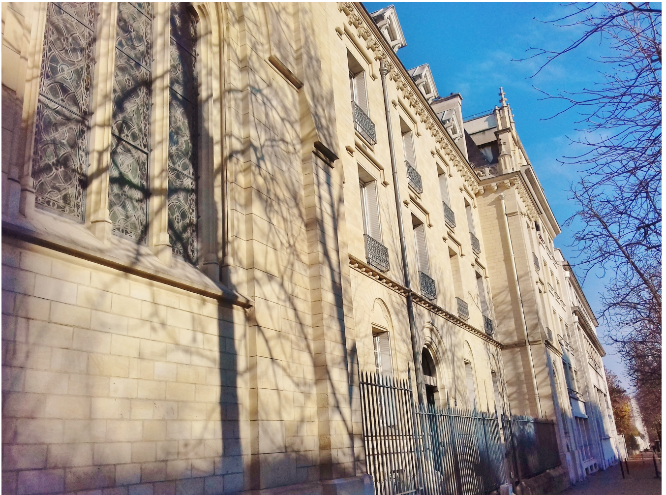
Façade du 102 boulevard Arago, Paris © Défap
