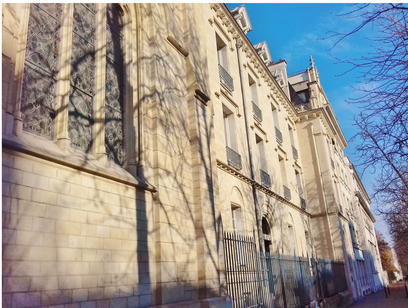
Façade du 102 boulevard Arago, Paris © Défap
