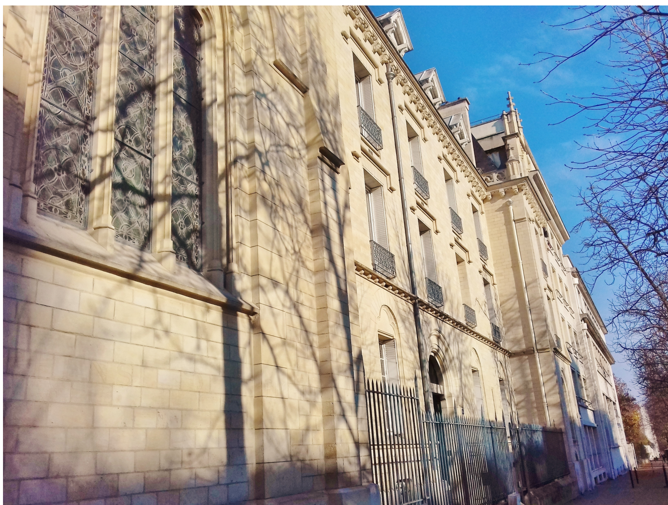
Façade du 102 boulevard Arago, Paris © Défap
