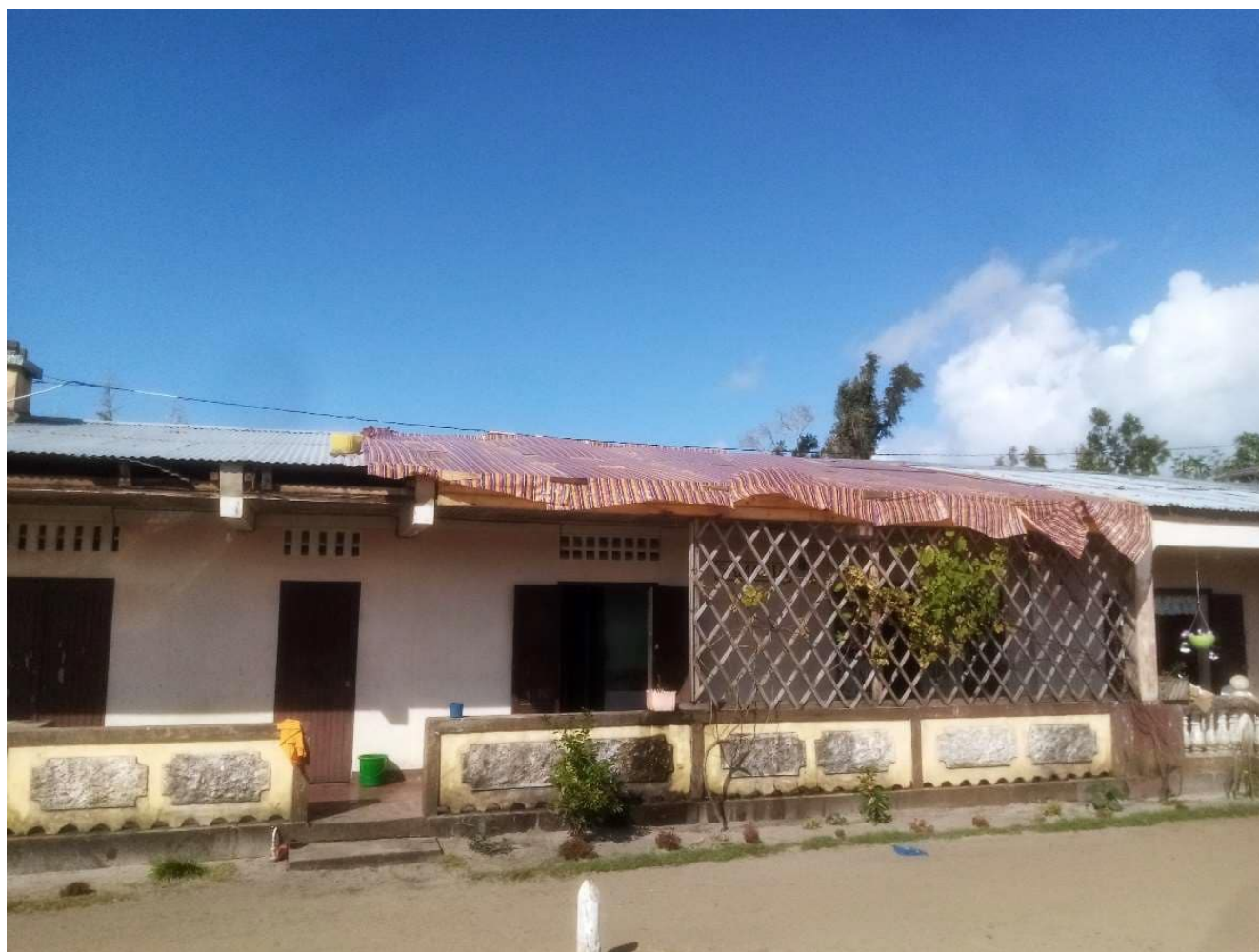
Pose d'une nouvelle charpente au Catja © ADRA
