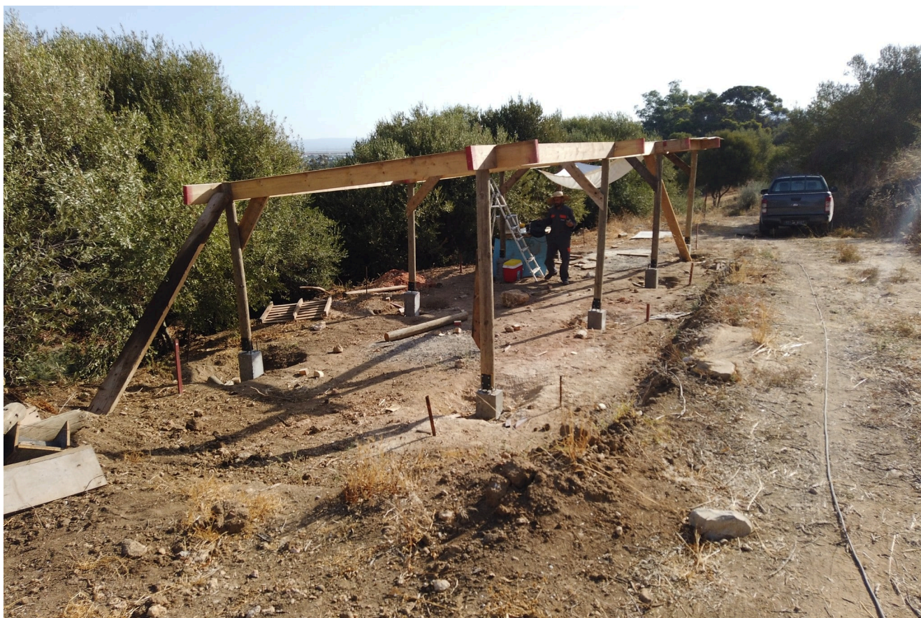
La construction de l'unité du projet avicole © DR
