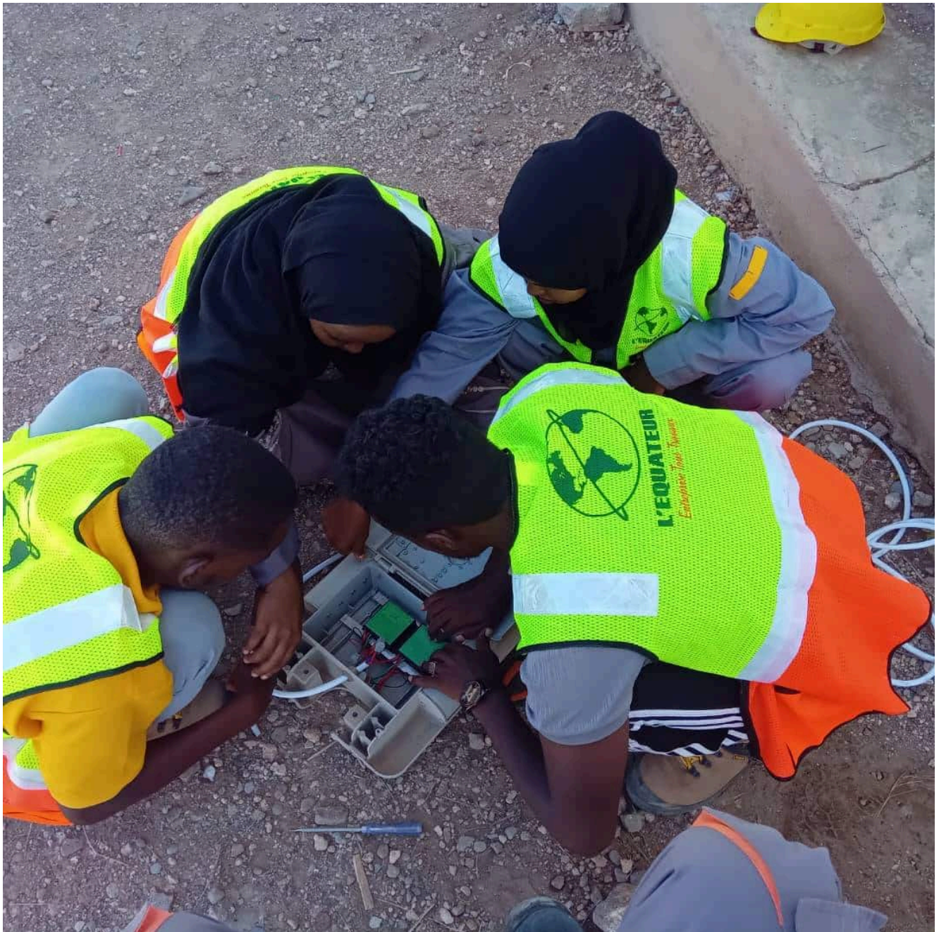
Jeunes du centre de formation de l'EPED lors d'une installation électrique fonctionnant grâce à des panneaux solaires © EPED
