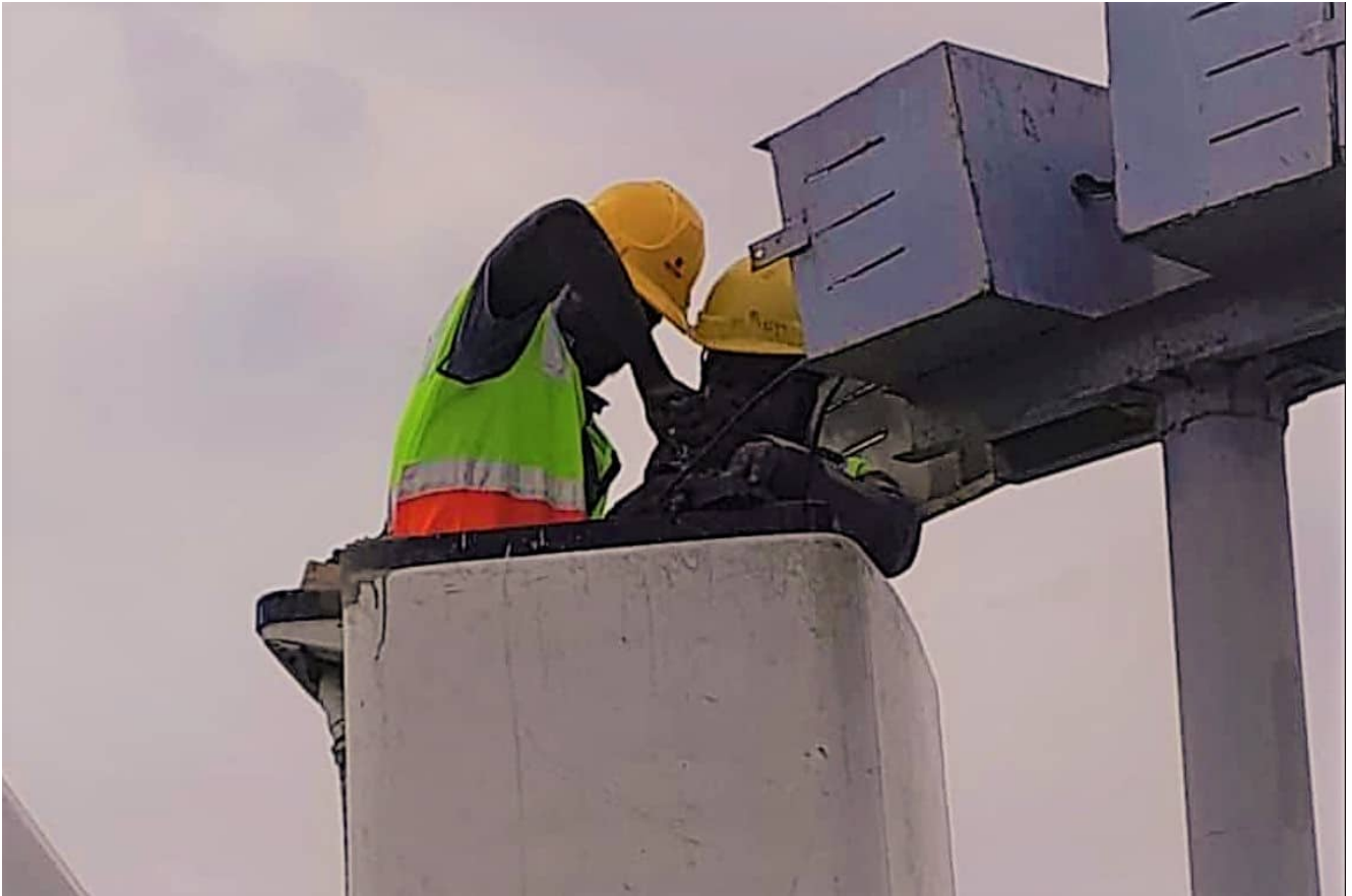
Jeunes du centre de formation de l'EPED lors d'une installation électrique fonctionnant grâce à des panneaux solaires © EPED
