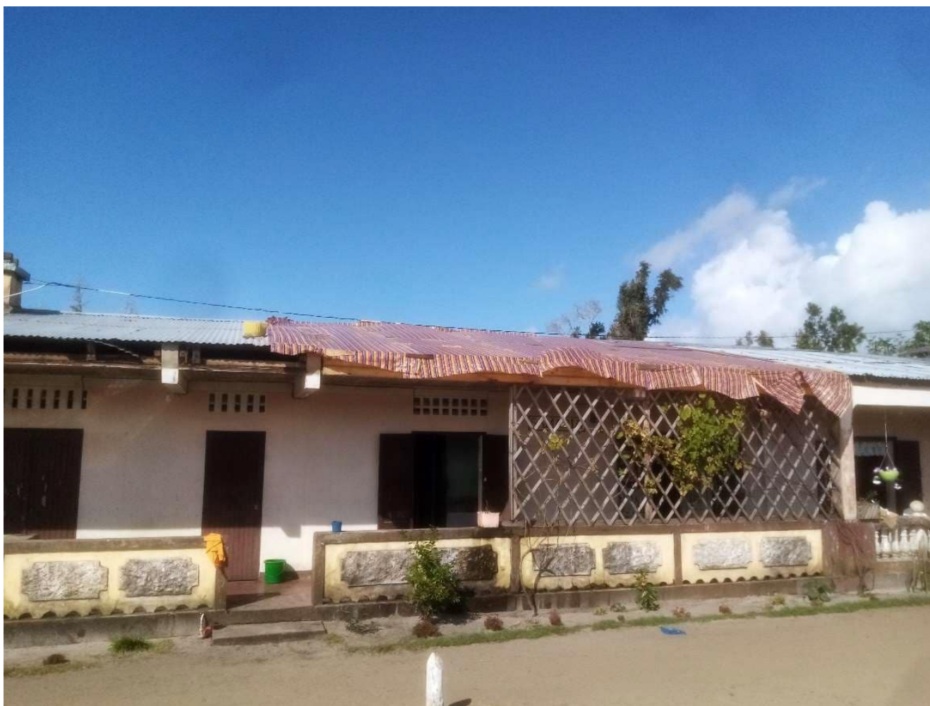
Pose d'une nouvelle charpente au Catja © ADRA
