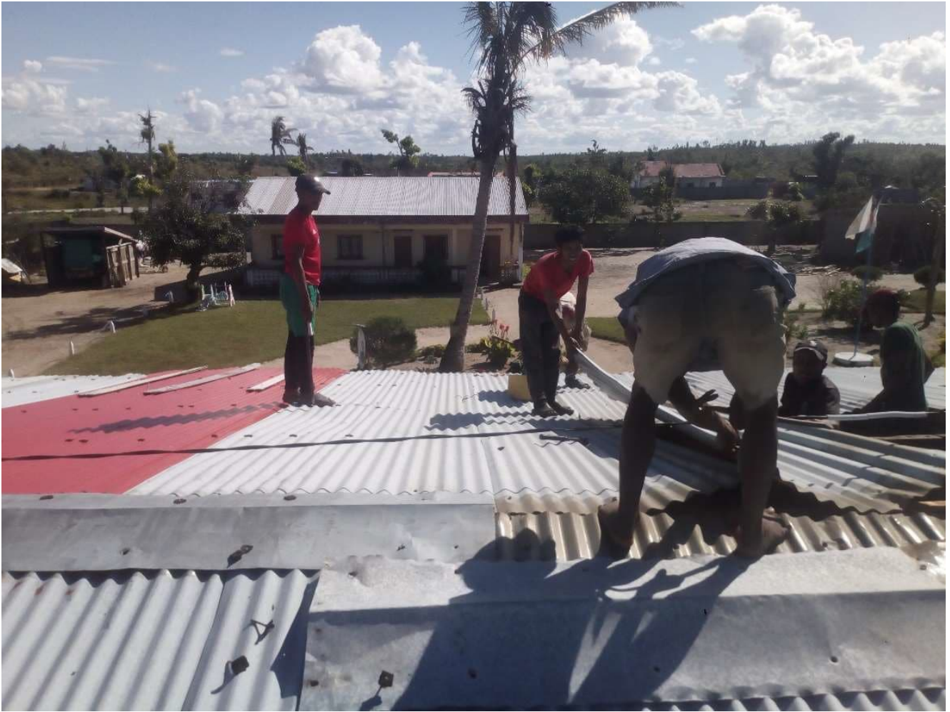
Vue des réparations sur le toit du bâtiment de la direction du Catja © ADRA
