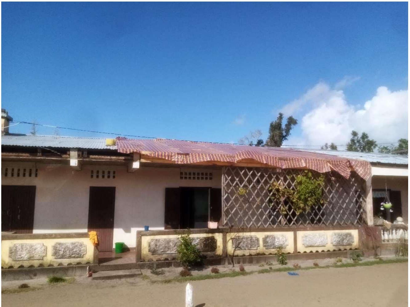
Pose d'une nouvelle charpente au Catja © ADRA
