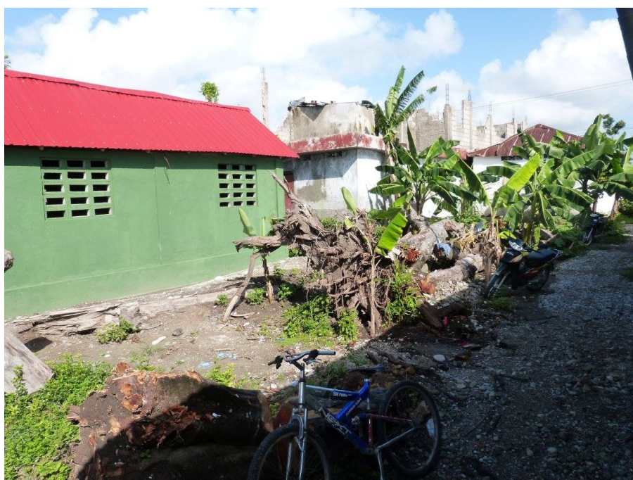
Etablissement réhabilité. La toiture légère répond aux normes de sécurité,
