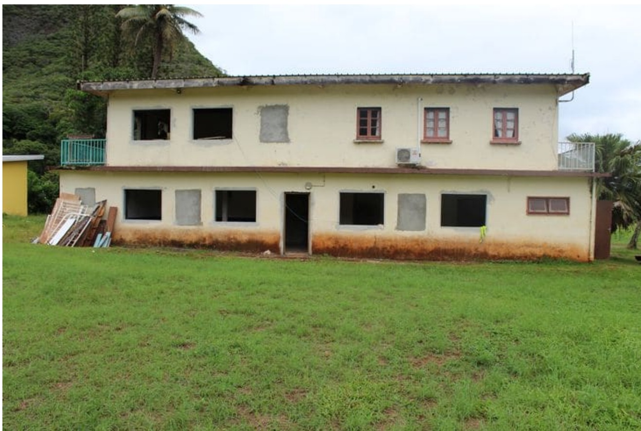
Le bâtiment administratif en pleine rénovation, 2017, DR
