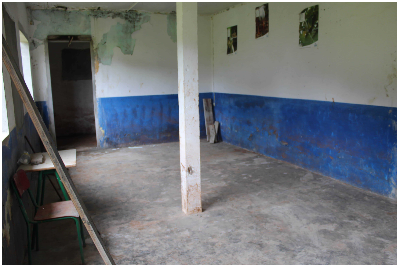
Travaux de l'espace vie scolaire, février 2017, DR
