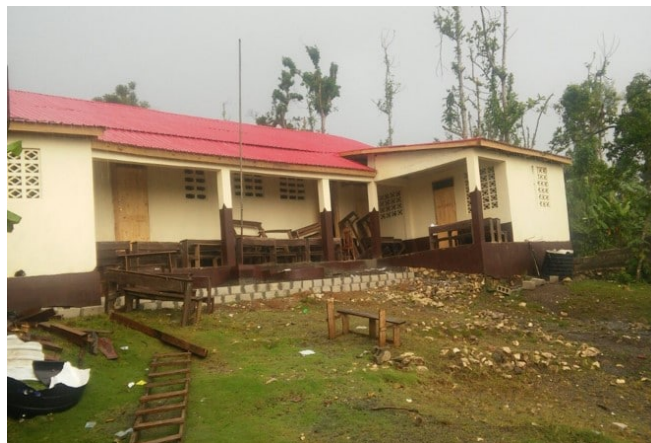
Ecole Bon Berger de Chambellan réhabilitée par la FEPH, DR
