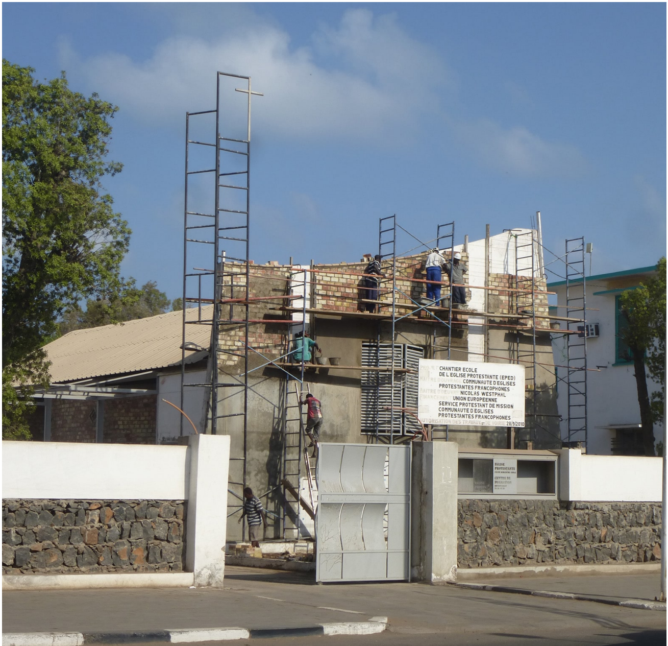
Le chantier, DR
